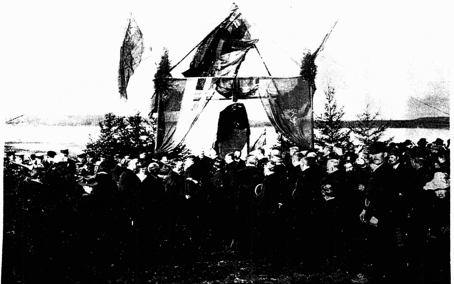
Minnesstenen vid Illberg avtäcktes vid en högtidlighet på 50-årsdagen efter banbyggets inledning den 5 maj 1899. Foto Arvid Kjerling. Från Sveriges Järnvägsmuseum
