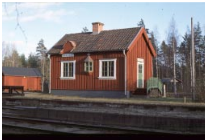
Göringens stationshus. Foto Christer Hammare.
